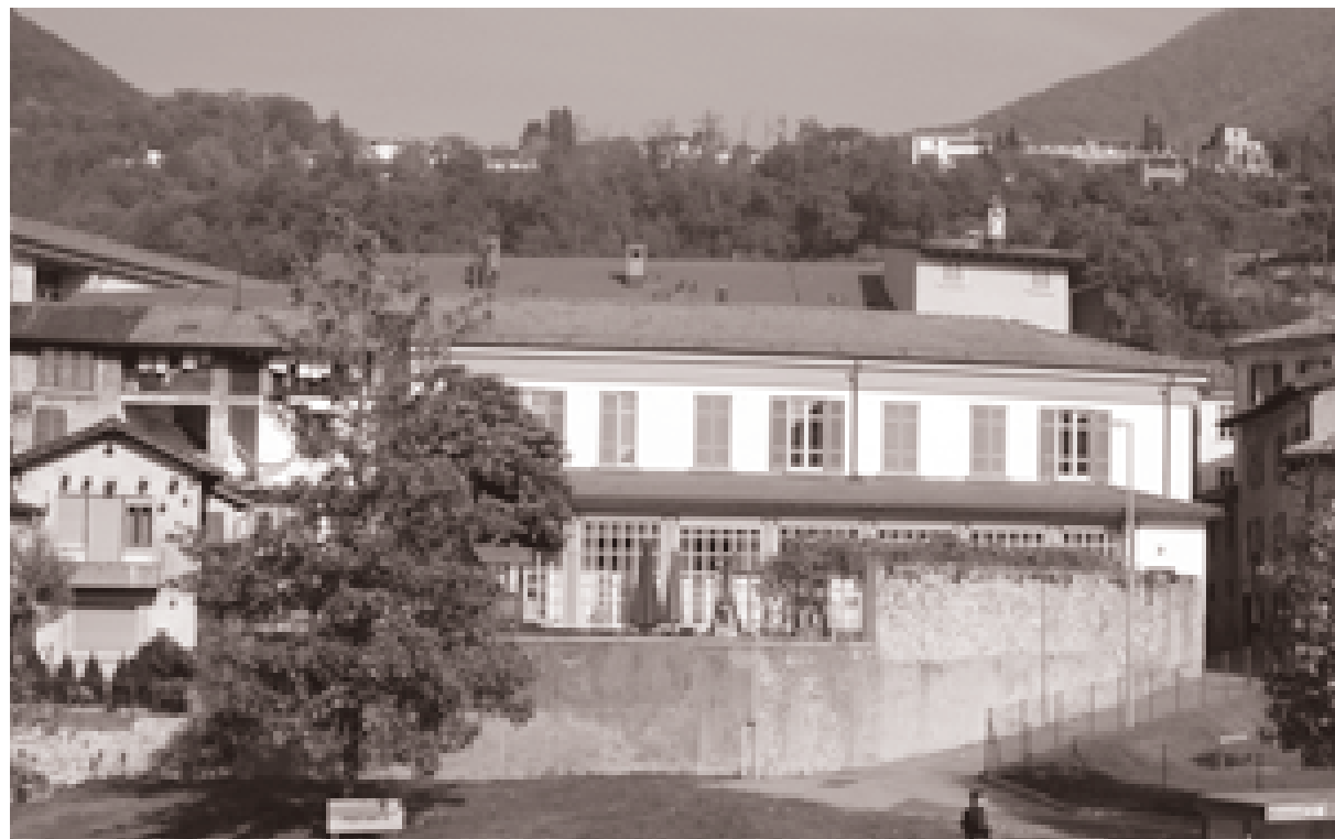
L'edificio che ospita l'Asilo nido Comunità dei bambini.
